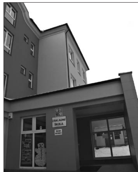
Občané volebního okrsku č. 252 mohli volit v nově zrekonstruované budově Základní školy v Halasově ulici. Foto: Karol Hercík
